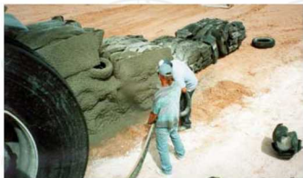
El lanzado de concreto con mezcla de bajo revenimiento, es uno de los muchos usos para la bomba de concreto LS-600.
